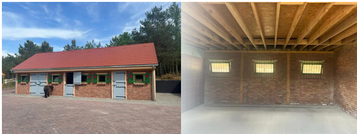
Budynek inwentarsko-składowy (małe zoo)
